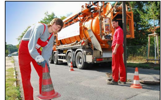
Auszubildende bei MAYER Kanal- und Rohrreinigung GmbH in Rüdersdorf bei Berlin
